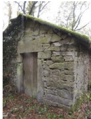
Fig.18 Detalle do aparello granítico da construción
