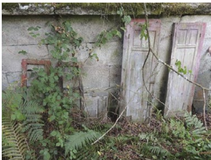
Fig. 31 Restos do labor en madeira dos marcos de vanos e portas
