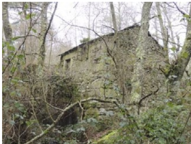
Fig. 12 Vista do muíño no seu conxunto enmarcando entre a frondosidade arbórea
