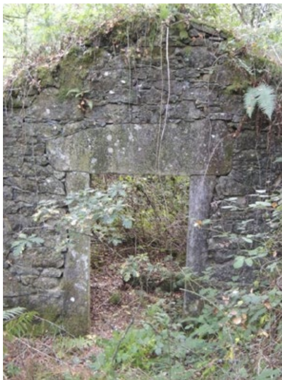
Fig. 57 Visión frontal de entrada á construción con porta adintelada que conserva un lintel de envergadura
