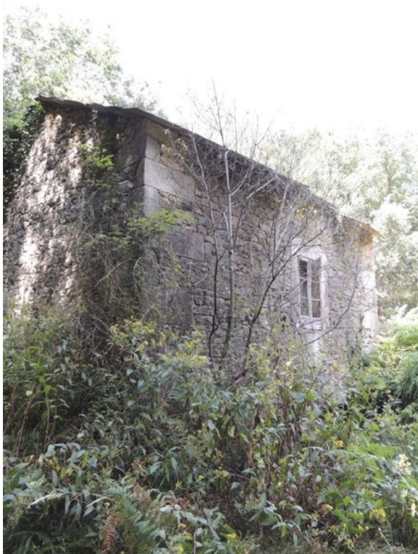
Fig. 3 Vista da fachada coa apertura do vano con marco de madeira con bastidor central e seis ocos ou orificios de paso de luz
