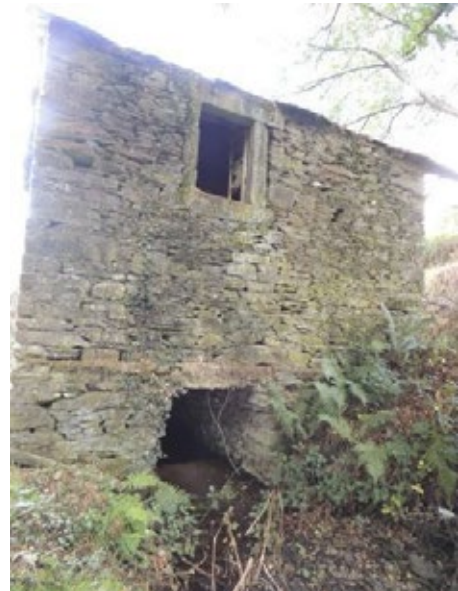
Fig.35 Detalle da fachada traseira do muíño coa abertura da canle
