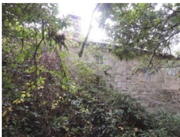
Fig. 2 Detalle da fachada traseira co desague do vertedoiro
