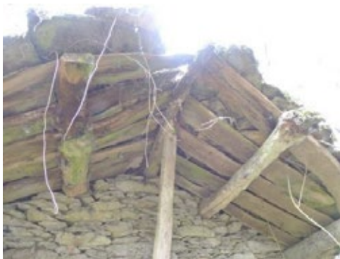
Fig. 12 Detalle do saledizo do teitume con pronunciada vertente
