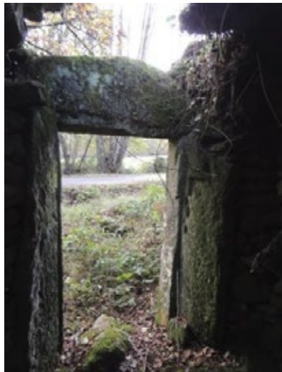
Fig. 13 Detalle do marco da porta granítico dende o interior cara o exterior
