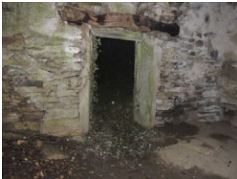
Fig.13 Vista dende o interior cara a porta exterior
