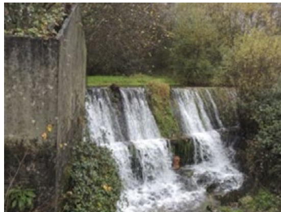
Fig.7 Salto de auga con caída escalonada.
