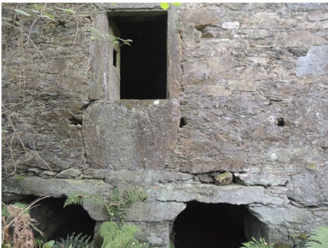
Fig.22 Vano de apertura de luz e ventilación visto dende o exterior
