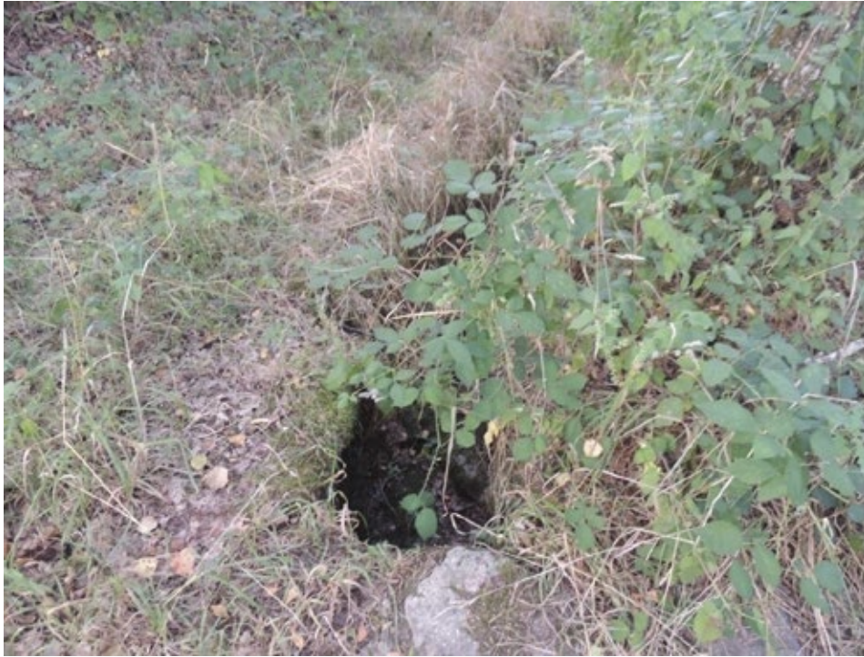
Fig. 6 Sistema de canalización a xeito de aceas para garantir o suministro de auga o muíño e poñelo en funcionamento
