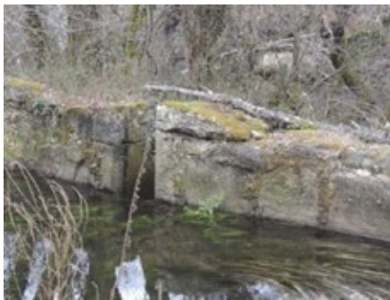
Fig. 4 Detalle das comportas do conxunto comprendido pola gabia e pola presa
