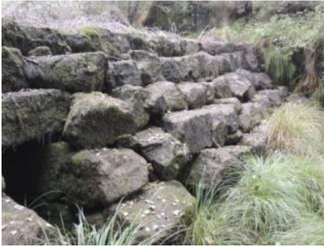
Fig. 4 Sistema construtivo da presa a base da superposición de pedras
