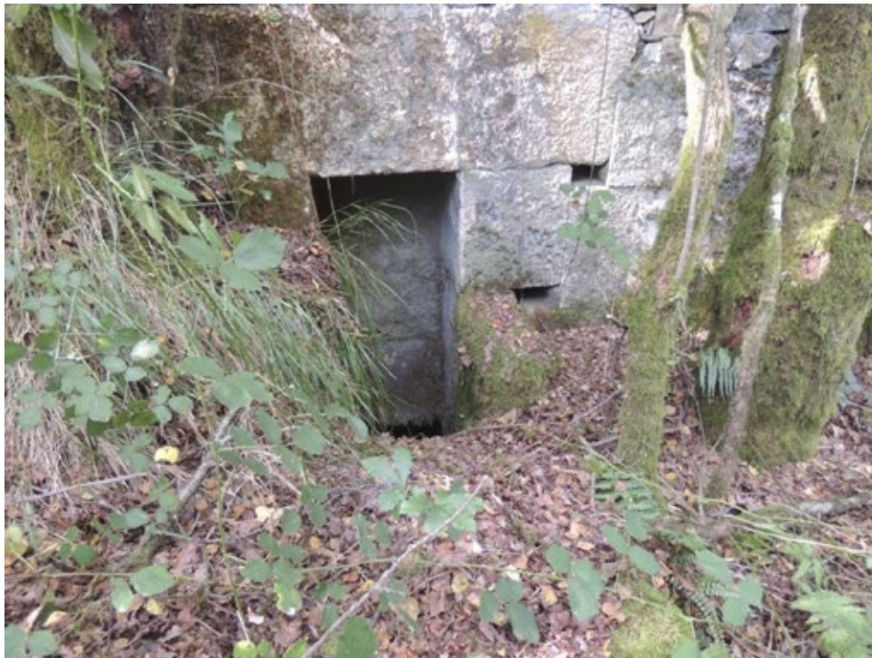
Fig. 33 Aperturas na construción para facilitar o paso da auga.
