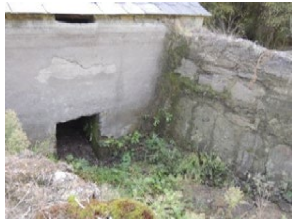
Fig. 9 Vista do oco para o paso da auga
