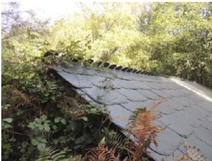
Fig. 2 Vista do lousado e o do seu asentamento no tellado a dúas augas.
