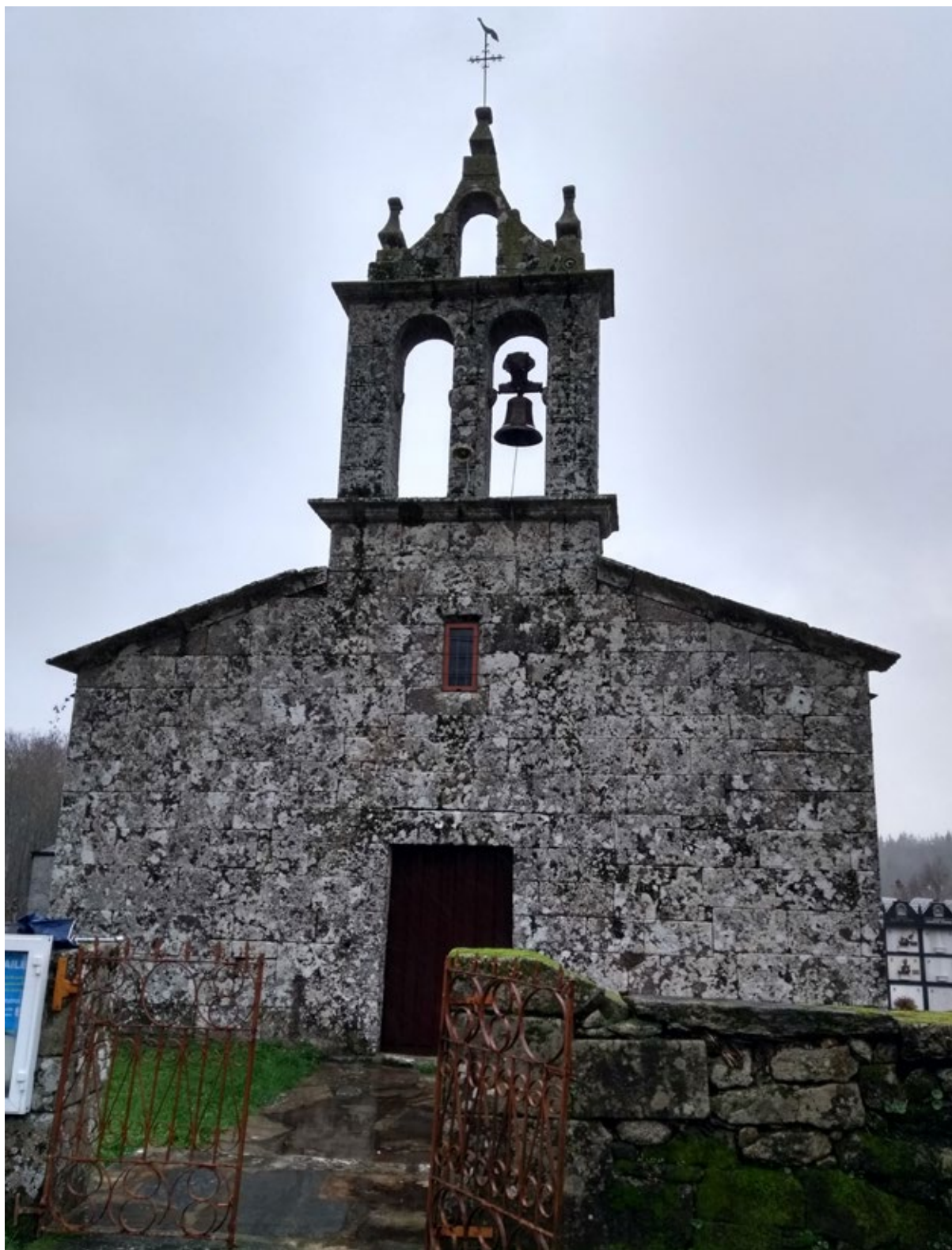
Fig. 53. Vista de San Paio de Silvela, setembro 2017. (Arquivo fotográfico da autora).
