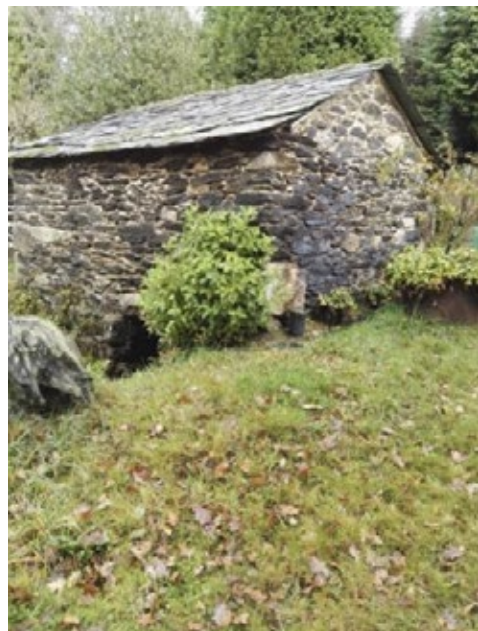
Fig. 87 Vista traseira coa súa característica mampostería de cor grisácea
