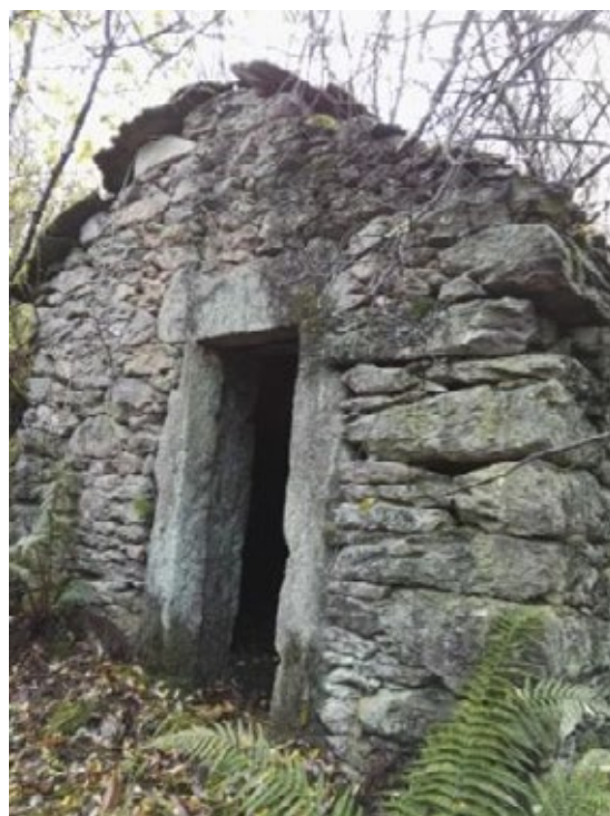
Fig. 90 Detalle da porta exterior de entrada
