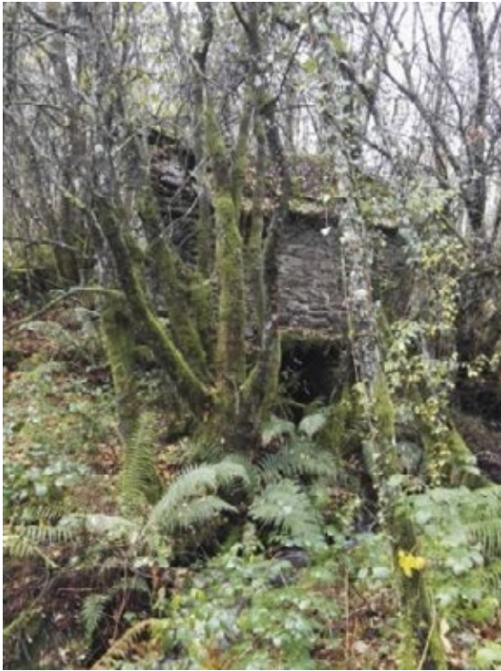
Fig. 91 Detalle da abertura da canle da auga.
