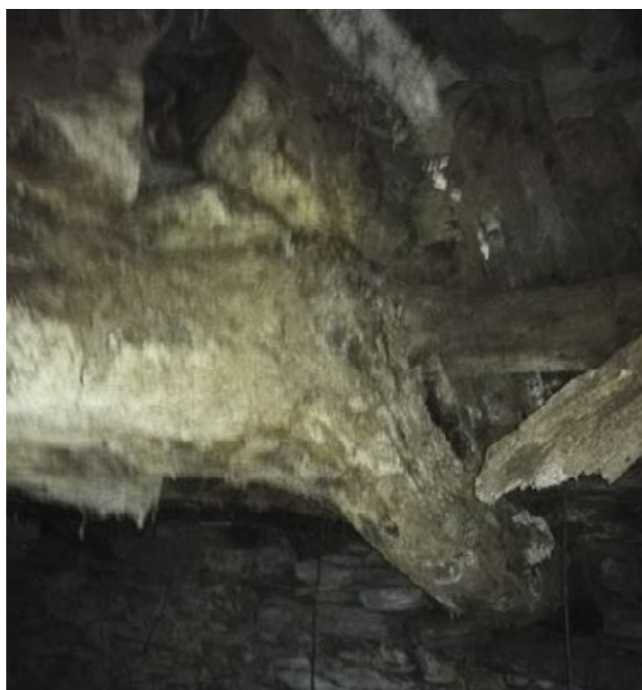
Fig. 42 Vista da robustez das vigas de madeira do teitume da construción.
