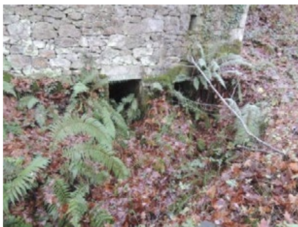
Fig. 15 Detalle das canles de entrada e saída da auga.
