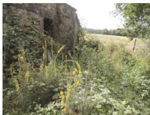
Fig.23 Detalle duns dos laterais da fachada
