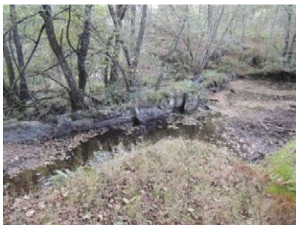
Fig. 20 Detalle da presa cos seus muros de contención
