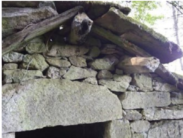
Fig. 6 Detalle do saledizo do teitume con gran proxección exterior
