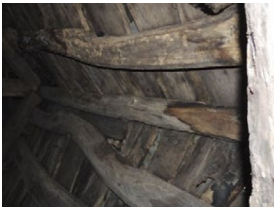
Fig.16 Detalle da rotundidade e bo ensamblaxe das vigas de madeira
