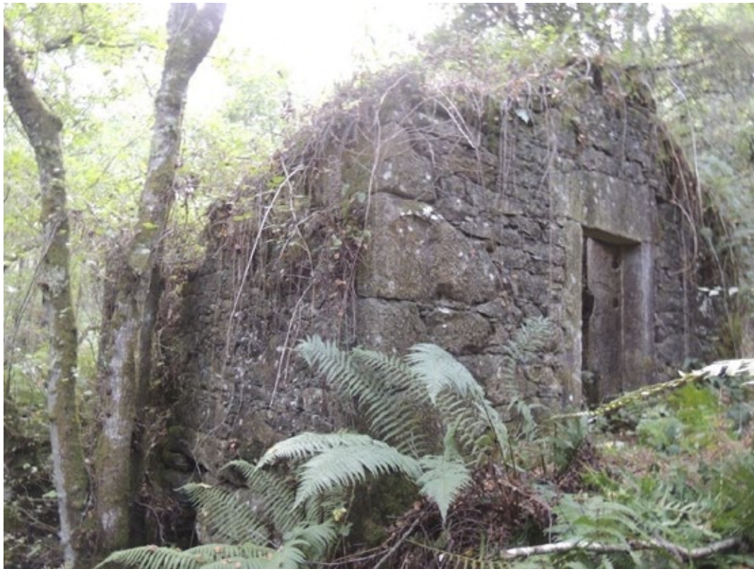
Fig.60 Vista lateral da fachada con caída que acentúa profundamente a verticalidade construtiva
