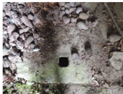
Fig. 11 Visualización da apertura cadrangular baixo a cal iría apostado o rodicio
