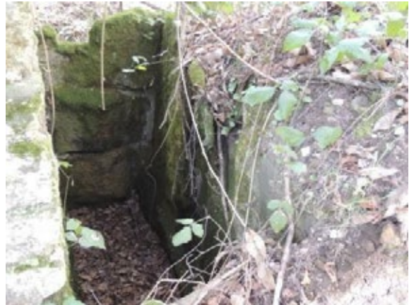
Fig.7 Depósito de almacenamento subsidiario á construción
