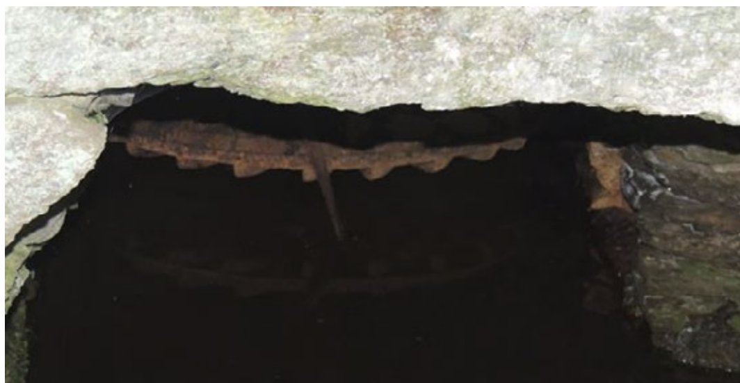
Fig. 23 Vista do rodicio coa posición xiratoria sobre a auga
