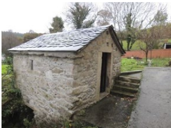
Fig. 72 Vista dende o outro lado da fachada
