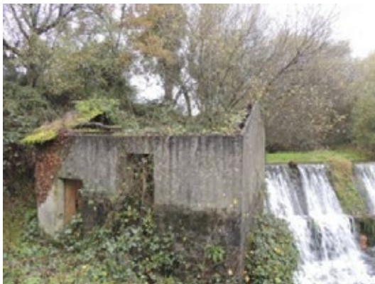
Fig. 5 Detalle do muíño co teitume descuberto
