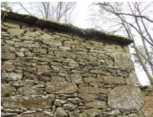
Fig. 18 Vista do magnífico paramento mural a base de sillares
