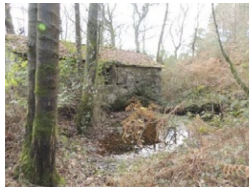
Fig. 19 Vista do muíño coa auga rodeando a construción
