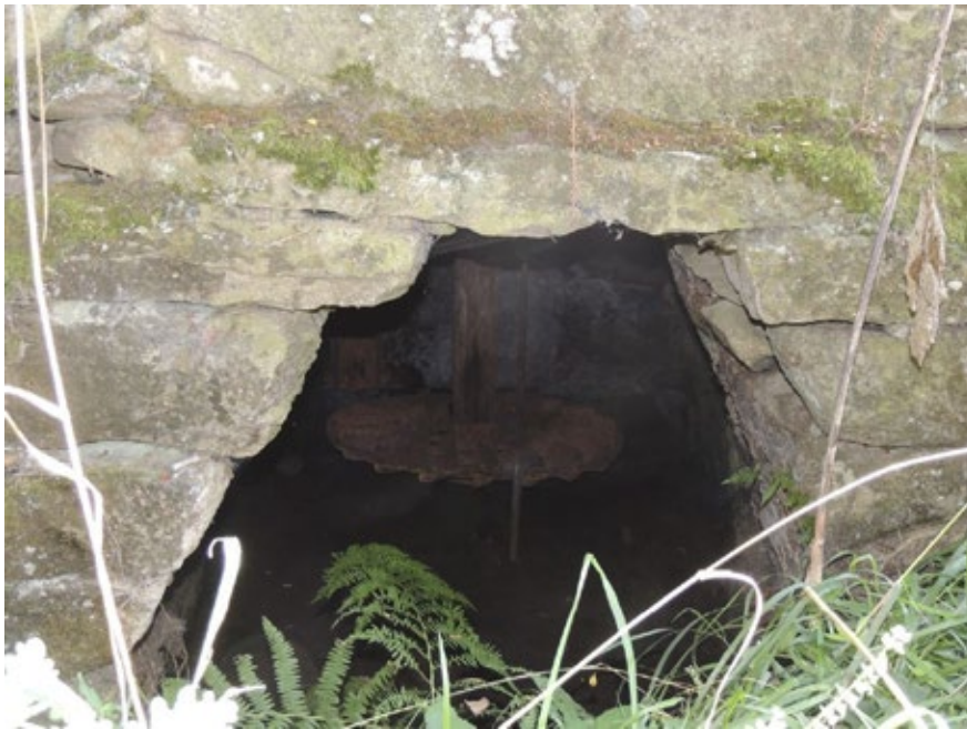
Fig. 56 Imaxe de rodicio acubillado nos baixos da construción e enmarcado pola abertura da canalización para a entrada da auga e activación da maquinaria hidráulica.
