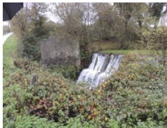
Fig.8 Vista do conxunto dende un lateral
