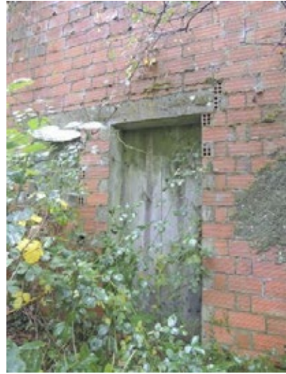
Fig. 2 Detalle de porta de acceso principal enmarcada entre tixolos.
