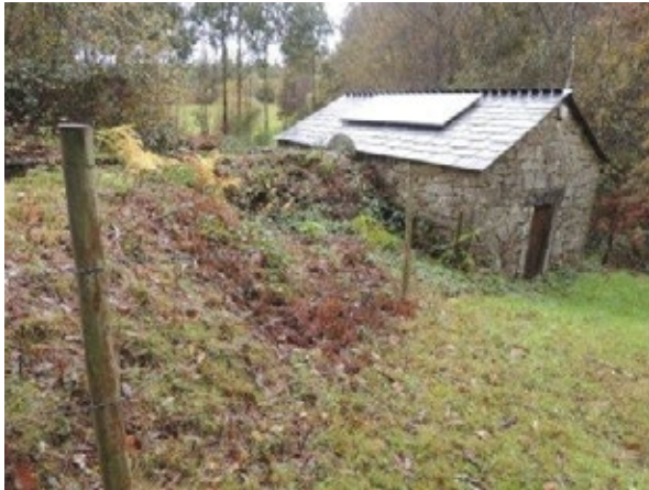
Fig. 74 Detalle da placa solar sobre o tellado do muíño.
