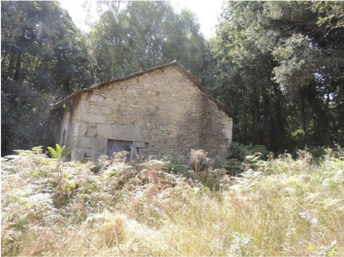
Fig.4 Vista da fachada co vano ou porta de acceso interior. Visibilidade dun bo aparello construtivo e de boa canteiría
