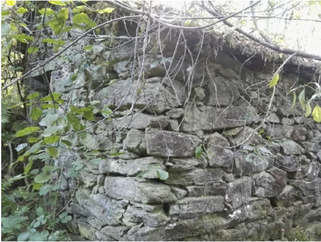
Fig.39 Mostra do aparello de pedra ao peche dunhas das esquinas ou esquinais.
