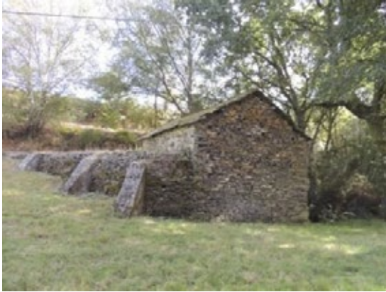
Fig. 32 Detalle da gabia fortalecida co sistema de contrarresto dos contrafortes
