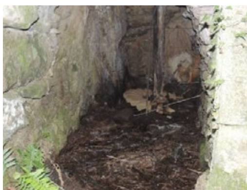
Fig. 20 Rodicio compañeiro doutro, xa deteriorado e inclinado
