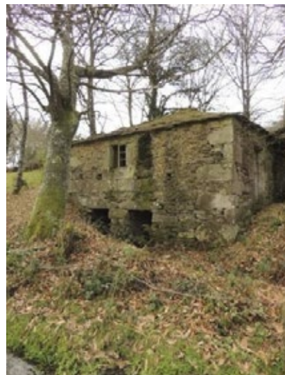
Fig.4 Visión da fachada principal coas xanelas e as aberturas das canles da auga
