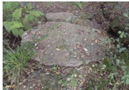
Fig. 9 Pontella como vía de comunicación e acceso
