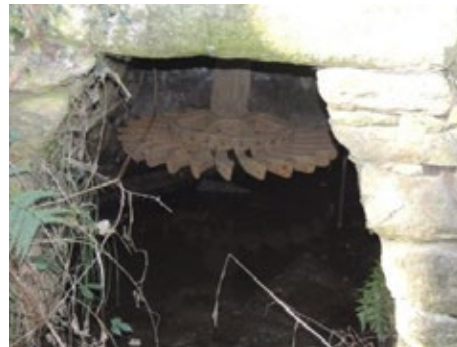
Fig. 2 Rodicio en suspensión, en bo estado de conservación
