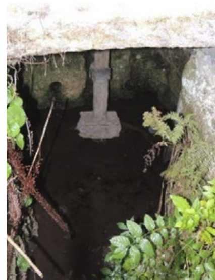
Fig. 73 Detalle do receptáculo do rodicio
