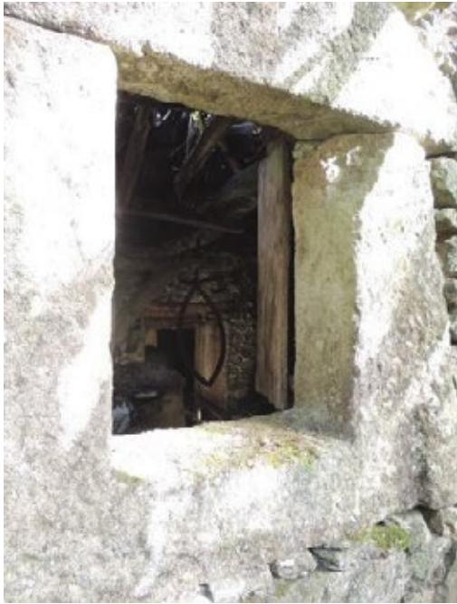
Fig.12 Ventá enmarcando o interior do muiño coa súa maquinaria característica
