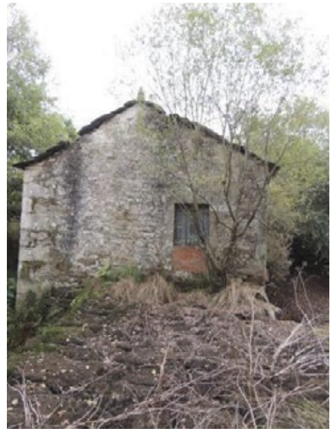
Fig. 5 Vista dun lateral do edificio.
