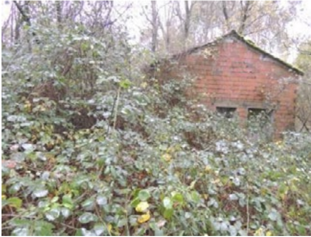
Fig.1 Vista da fachada principal co engadido do ladrillo.
