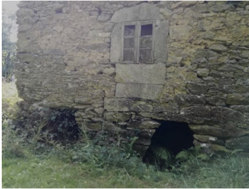
Fig. 50 Aperturas para facilitar a canalización e suministro de auga ao muíño.
