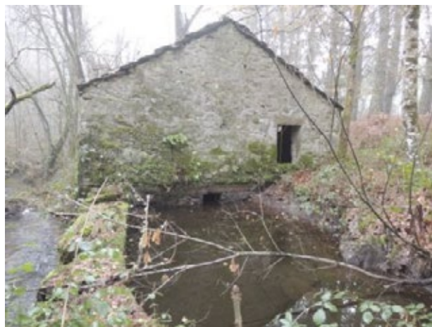
Fig. 4 Fachada lateral en conexión co depósito de auga da presa.
