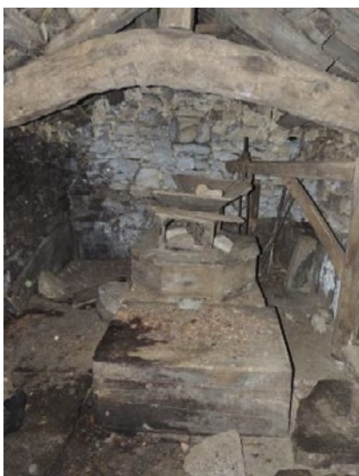
Fig. 13 Interior en bo estado de conservación (teitume integra)
