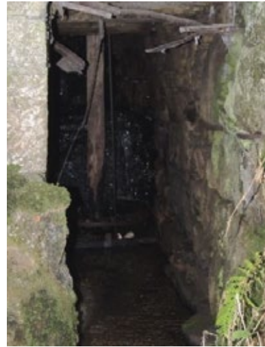
Fig.5 Vista do rodicio, pertencente á estrutura da maquinaria
