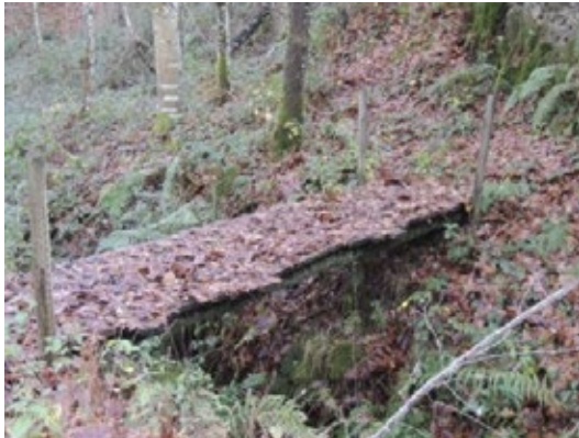
Fig. 1 Detalle da pontella de acceso de vía de comunicación
