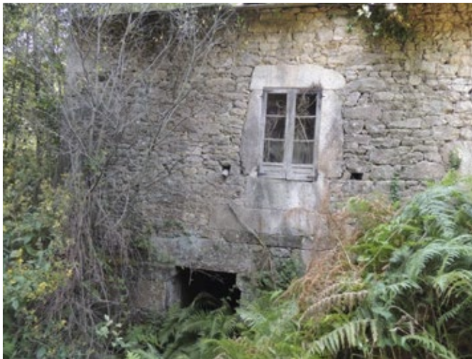
Fig. 1 Vista da fachada coa canalización subterránea da auga
