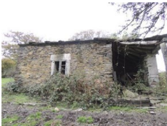
Fig.7 Vano de madeira centralizando a construción
