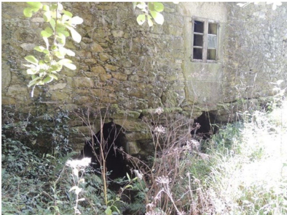
Fig.52 Vista das arcadas de abertura do muíño que cobixan os rodicios.
