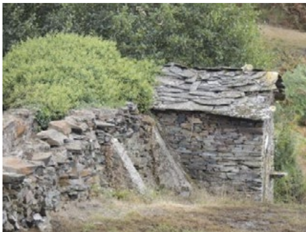
Fig. 28 Detalle da adaptación ao escarpado do terreo
