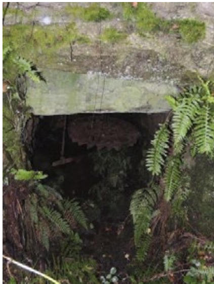
Fig. 3 Abertura da canalización da auga
