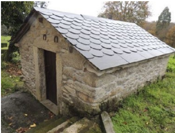
Fig. 71 Vista do muíño totalmente reformado
