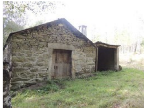
Fig. 2 Fachada principal co engadido dun cobertizo
