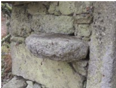
Fig. 3 Detalle de saínte na parede, a xeito de mensulón, posiblemente tamén para colocar o saco
