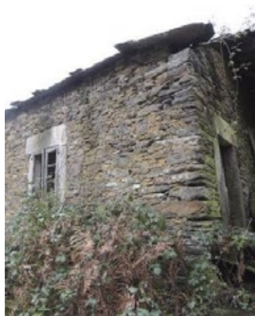
Fig.9 Vista pormenorizada do aparello construtivo
