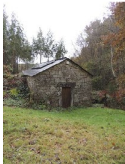
Fig. 77 Vista da fachada principal do muíño.
