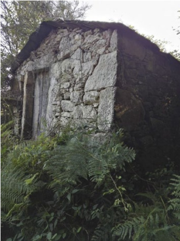
Fig. 43 Detalle en esquina da fachada (boa labra dos sillares)
