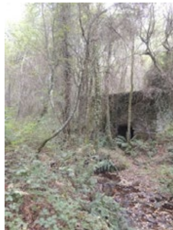
Fig. 15 Detalle da abertura da canle para a auga
