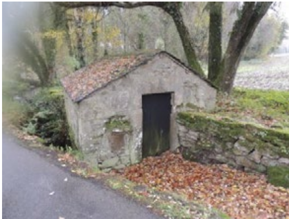
Fig. 9 Vista da fachada principal da edificación
