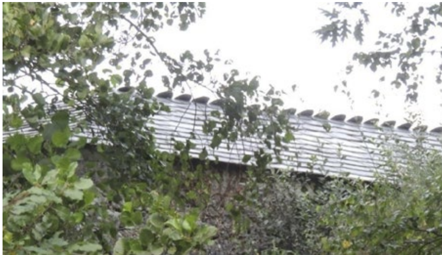
Fig. 9 Visión da teitume perfectamente lousada con disposición das lousas a dúas augas, e con saíntes de lousas en aresta a xeito de coroamento externo
