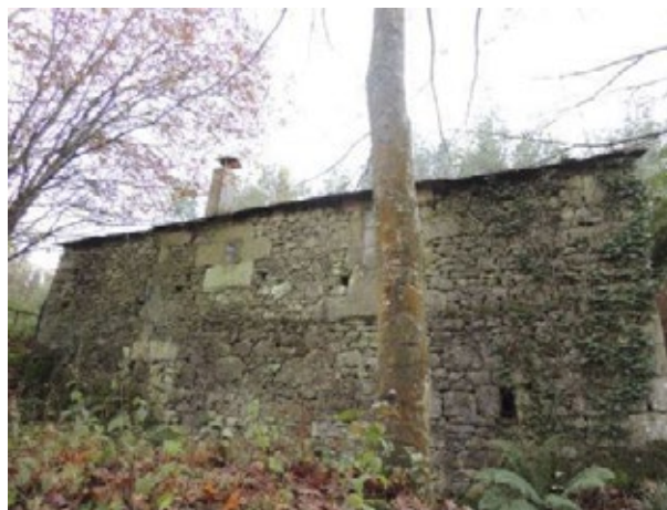
Fig. 14 Fachada traseira do muíño
