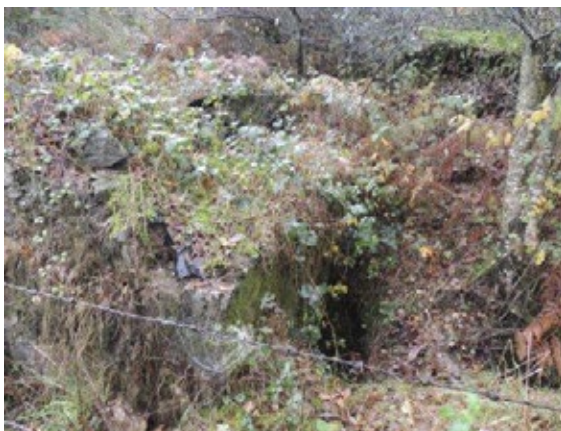
Fig. 67 Estrutura cuberta totalmente pola maleza.
