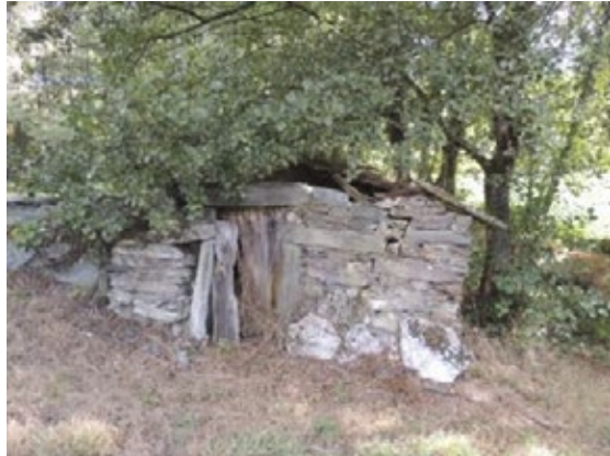
Fig. 38 Vista principal da fachada xa destartalada
