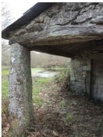
Fig. 11 Detalle da presa enmarcada polo pórtico adintelado
