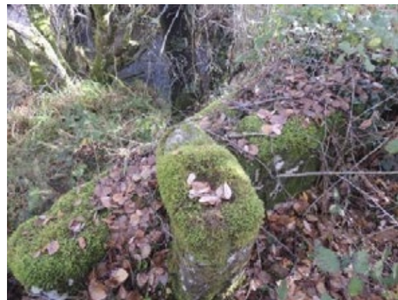
Fig. 10 Visión dende arriba dos restos que quedan do muro de construción
