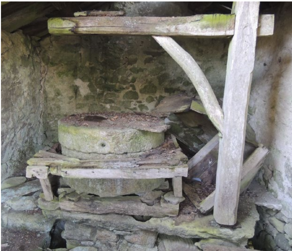
Fig.16 Restos da maquinaria interna que conserva as pedras e a estrutura de moenda case en perfectas condición
