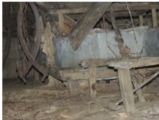
Fig. 17 Detalle do interior bastante deteriorado
