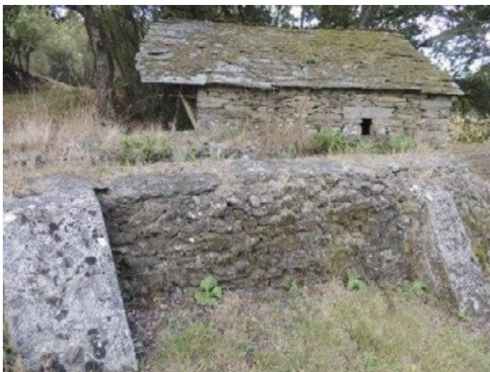
Fig.36 Perímetro da gabia cos contrafortes
