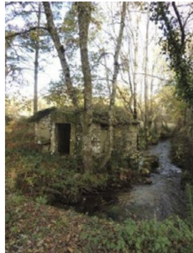
Fig.12 Detalle da edificación inserida na súa contorna
