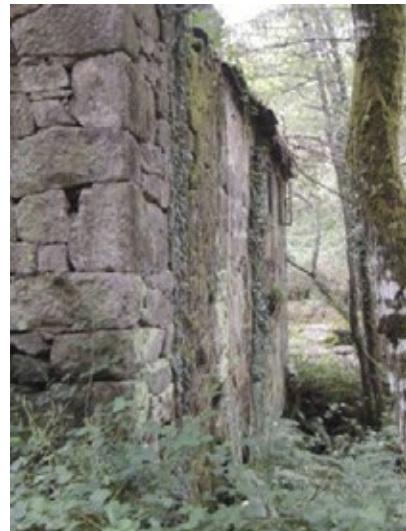
Fig. 7 Detalle dun esquinale coa visibilidade da boa cantería.
