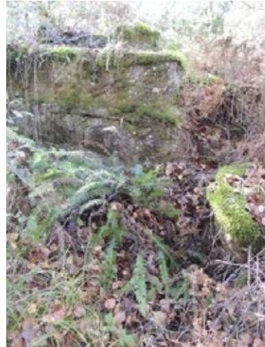
Fig. 8 Desenvolvemento en altura dos restos do muro (verticalidade fronte á horizontalidade das fiadas)
