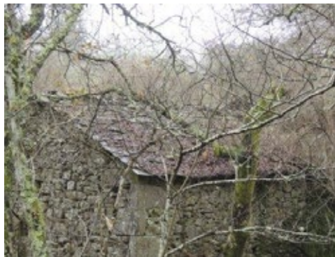
Fig. 8 Vista de detalle do lousado en boas condicións de conservación.
