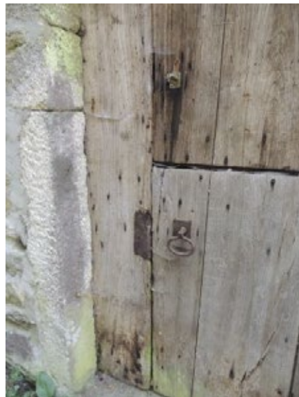
Fig. 10 Porta característica de madeira, con petadores e peches con arandela de ferro
