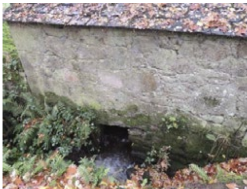
Fig. 13 Detalle da abertura da canalización da auga.
