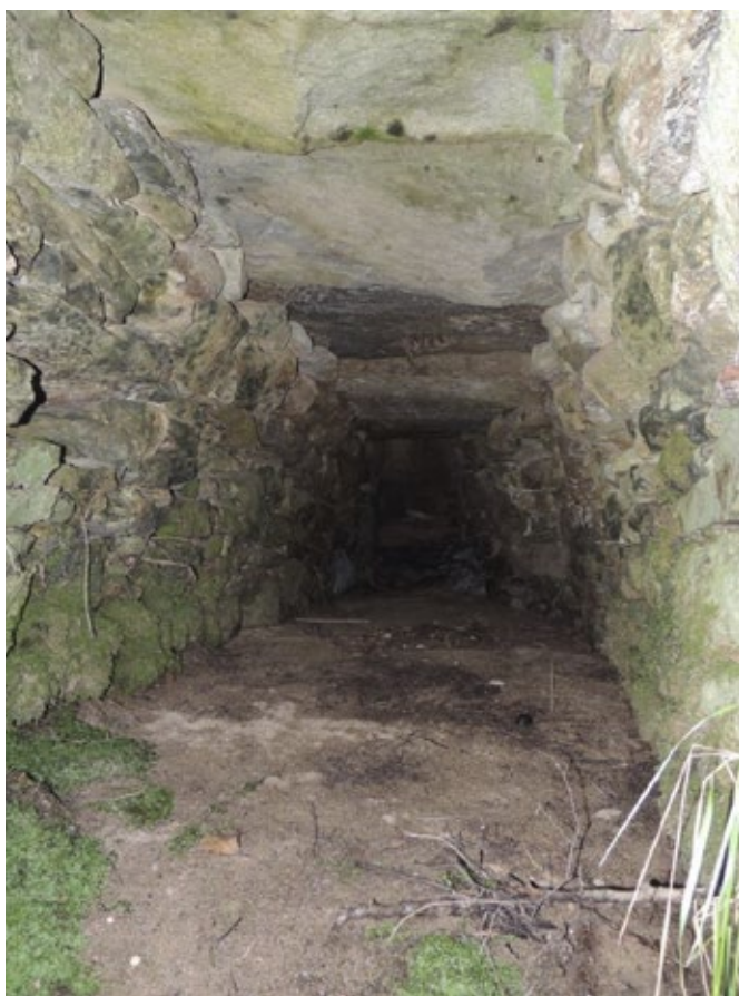
Fig.61 Vista en forma de túnel da parte subterránea do muíño onde se colocaría o rodicio con conexión coa 1ª pranta a través dun orificio.
