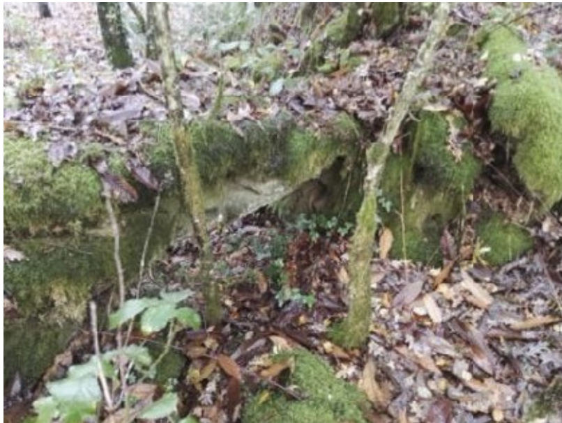
Fig. 98 Restos da gabia.
