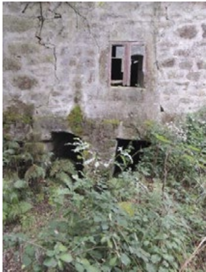
Fig. 3 Detalle dun vano e dúas aberturas de canle
