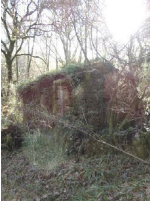
Fig.3 Vista da fachada traseira
