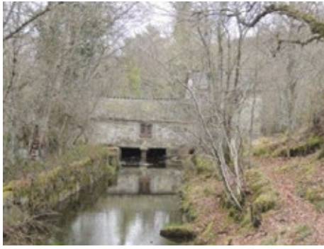
Fig.3 Vista do canal lonxitudinal da gabia e da recepción da auga polo muíño a través das súas canles
