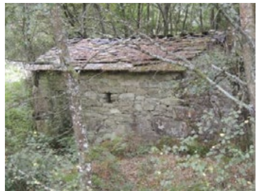
Fig. 2 Vista lateralizada da construción do do tellado
