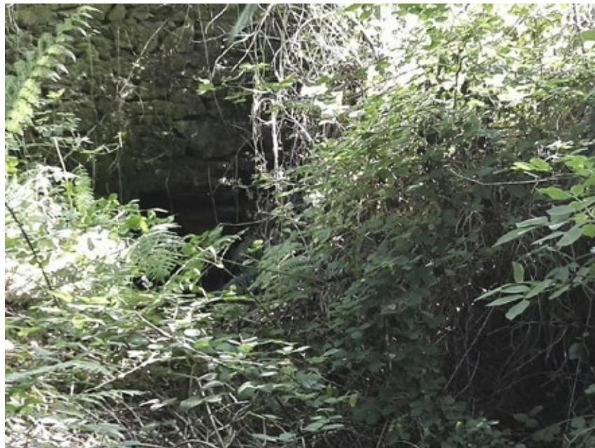
Fig. 36 Arredores e canalización da auga do muíño invadidos de maleza.
