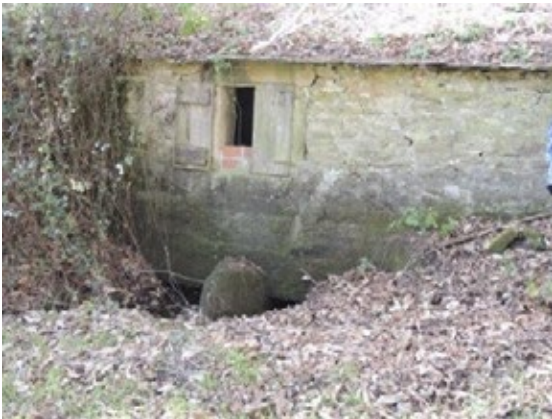
Fig. 6 Recepción da auga polas entradas das canles
