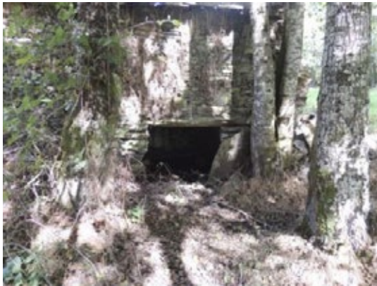
Fig. 39 Vista da parte traseira da fachada
