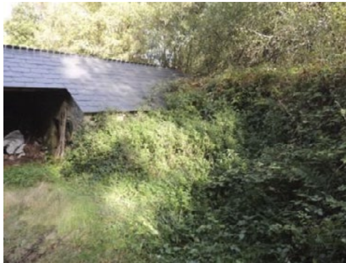
Fig. 1 Vista do acceso á entrada principal.
