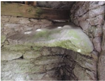
Fig. 9 Saledizo identificado como a cambota dunha cheminea e para tornar a calor do teitume da madeira, como medida preventiva
