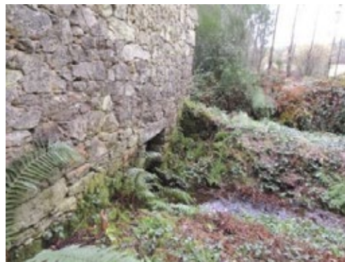
Fig. 78 Vista da entrada e saída da auga pola canalización.
