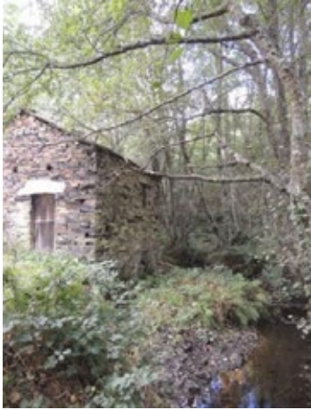
Fig. 24 Fachada traseira onde se apostan os rodicios e as canles da auga
