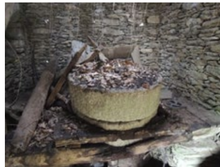
Fig. 13 Detalle do interior coa pedra de moer
