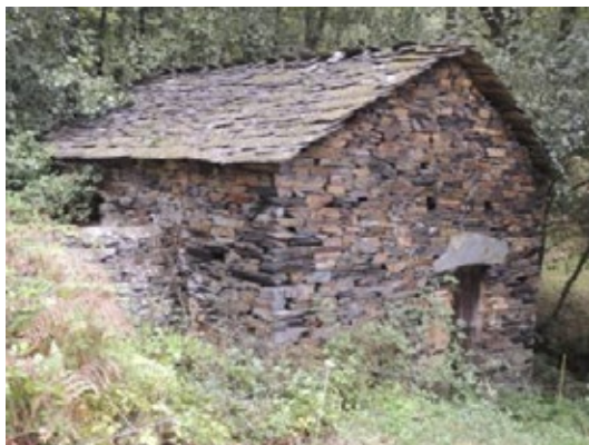
Fig. 22 Vista da fachada principal da construción
