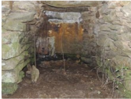
Fig. 11 Receptáculo de ubicación do rodicio
