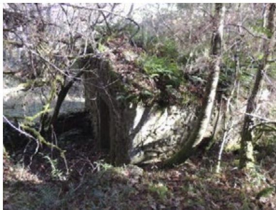
Fig. 2 Vista tomada dende o camiño, só se vislumbra dificultosamente parte do teitume
