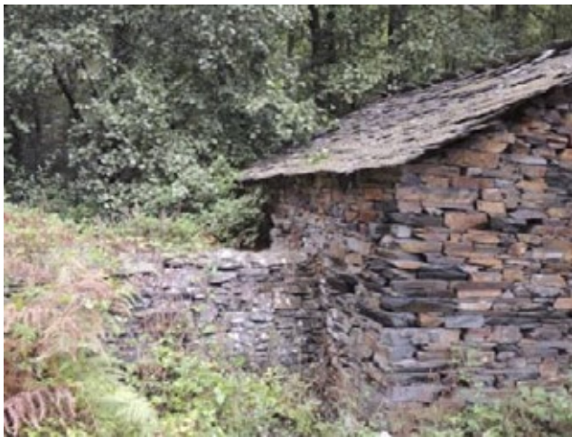
Fig. 26 Detalle da recepción da auga por parte da gabia
