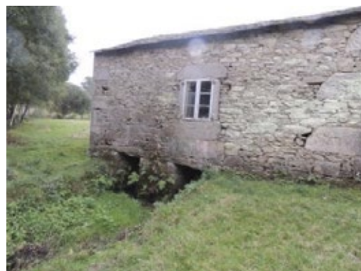
Fig. 10 Visión das canles coas súas aberturas cadrangulares
