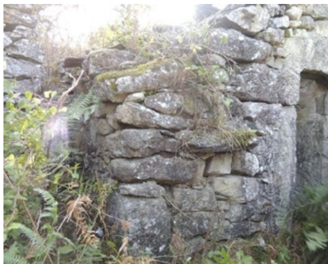
Fig.15 Visualización da pedra externa que serve de sustento o saco de grao para pousalo
