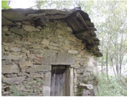
Fig. 5 Vista do saledizo da teitume
