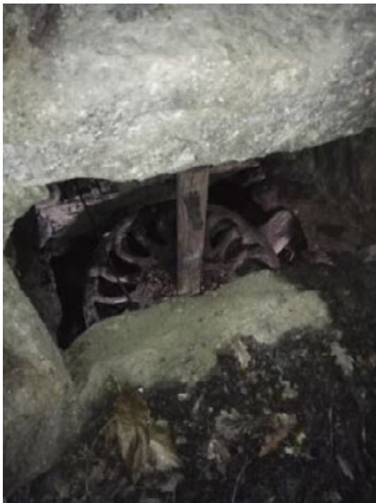
Fig. 94 Vista de rodicio en ubicación orixinal e presentando bo estado de conservación
