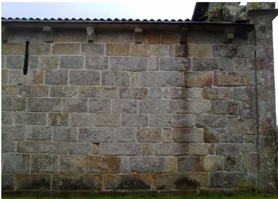
Fig. 40. Detalle dos canzorros e seteira orixinal de Nodar, setembro 2017. (Arquivo fotográfico da autora).
