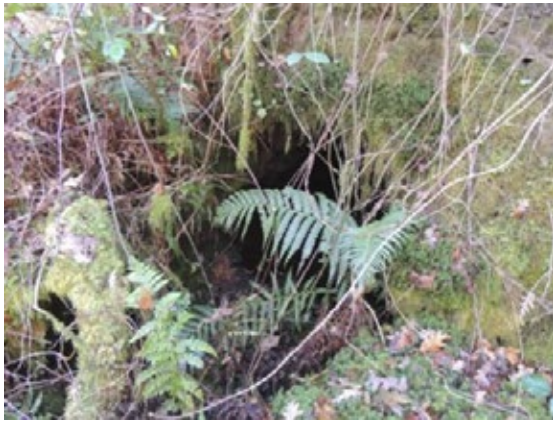
Fig. 5 Orificio de abertura para a canalización de entrada e saída da auga
