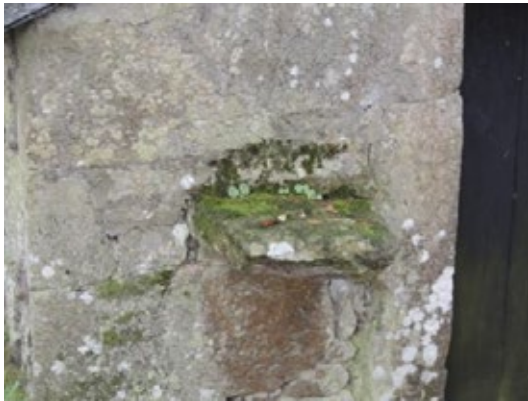
Fig. 11 Detalle da pedra de pousar o saco para levar o gran a moer
