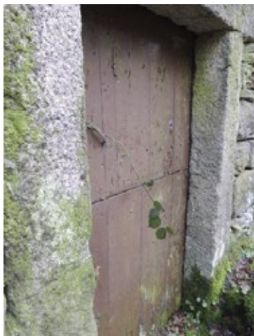
Fig. 11 Porta de entrada en cor marrón en bastante bo estado de conservación.
