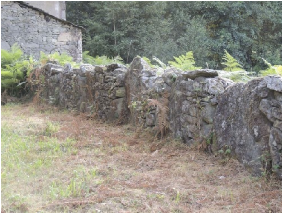
Fig. 8 Muros de peche de pedra nos que se combina a verticalidade do chanto de pedra e a horizontalizade de pequenos croios apilados para chegar á altura do chanto e conformar a estrutura de cerramento, a xeito de cinto perimetral.
