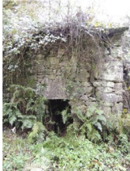
Fig. 64 Detalle da abertura rectangular de saída da auga
