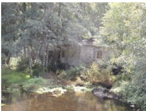
Fig.3 Vista do muíño enmarcado polo arborado e mecido polas augas do río.
