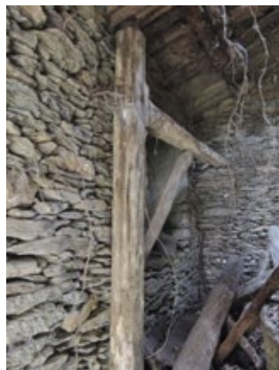
Fig.14 Grúa ou guindastre de manipulación nas tarefas de moenda
