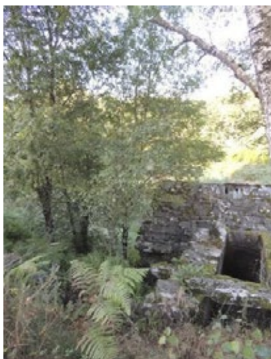
Fig.15 Mostra da cubeta que recolle a auga transportada pola gabia
