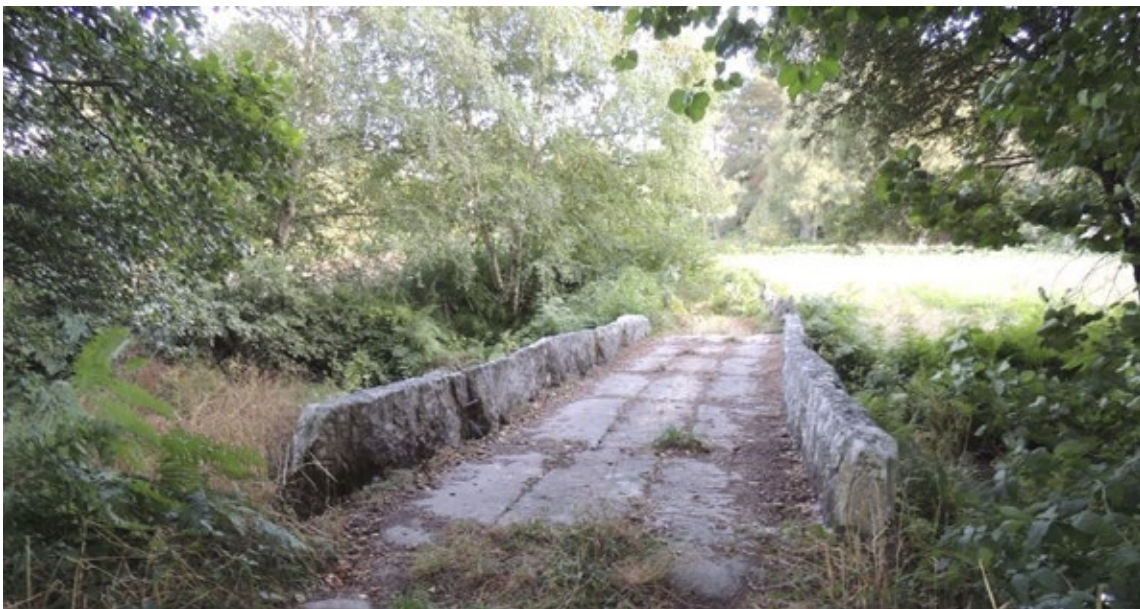
Fig. 7 Magnífico exemplar de ponte de arquitectura civil para conectar o muíño coa vía do camiño, obsérvese a calidade e traballo dos sillares de pedra e a súa calidade e verticalidade no pavimento e nas barandillas laterais.
