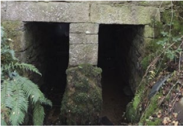
Fig.4 Detalle da barra divisoria de ambas canles
