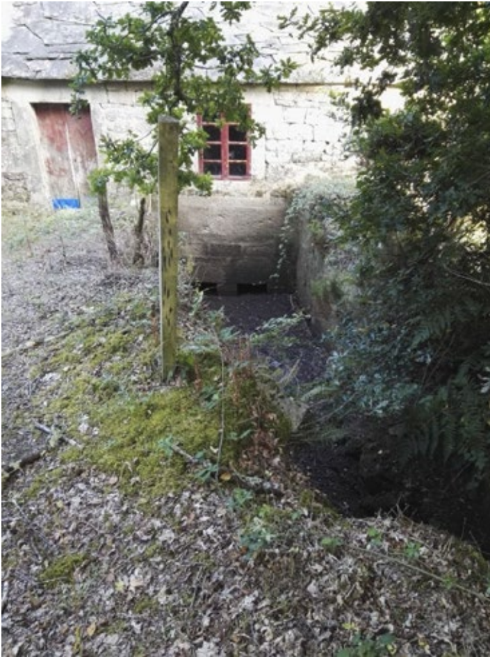
Fig.46 Vista da fachada ao descender pola costa que antecede o seu acceso
