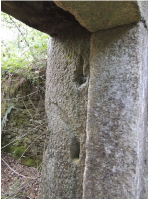
Fig. 59 Restos das aberturas dos goznes e bisagras sobre os que pivotaría a porta de acceso
